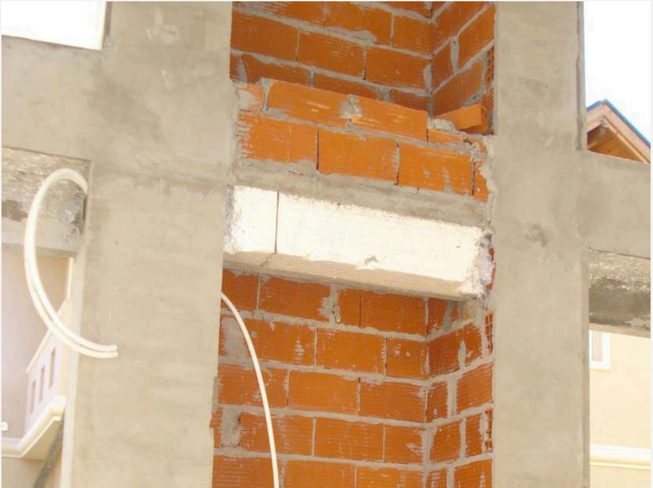
**Figura 3.** El tamaño de las piezas de poliestireno expandido dependerá de las dimensiones y tipo de cajón correspondiente a la altura de la carpintería proyectada.
