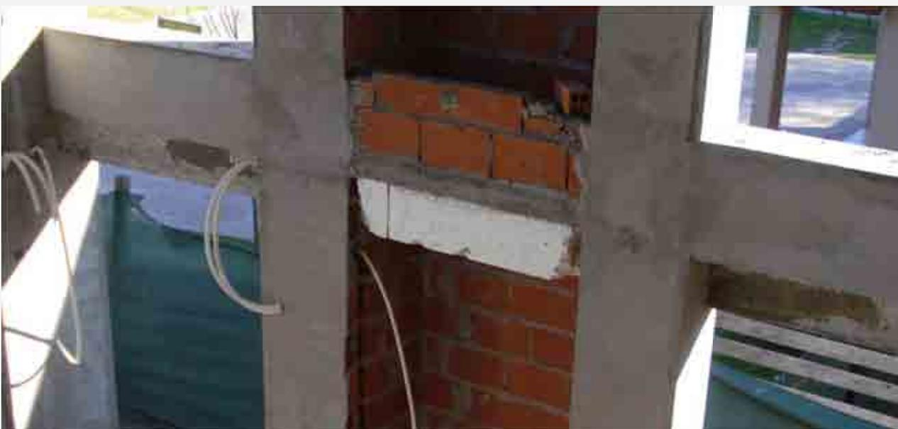
Figura 2. Piezas de poliestireno expandido que facilitará a futuro la instalación del Sistema Compacto.
